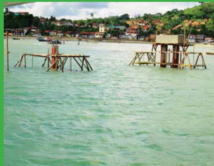
Figura 4. Atracadouro em construção, com desembarque com uso de canoa, ao fundo. Praia Grande, Ilha de Maré, 30/07/2010, Fotografia: Rosiléia Oliveira de Almeida.
