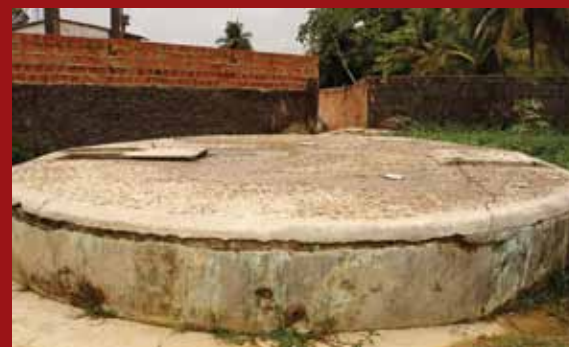
Figura 6. Fonte da Malhada. Santana, Ilha de Maré, 2007. Fotografia: Rosiléia Oliveira de Almeida.
